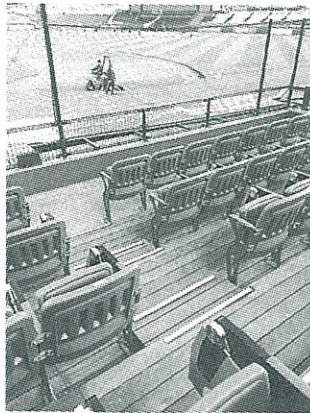
野球場の2年度ある実績の、このほど改修が行われ、目の施工を実施した
